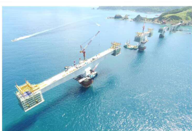
甑大橋(甑島)（鹿児島県薩摩川内市）
