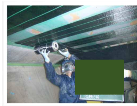
炭素繊維シート補強
