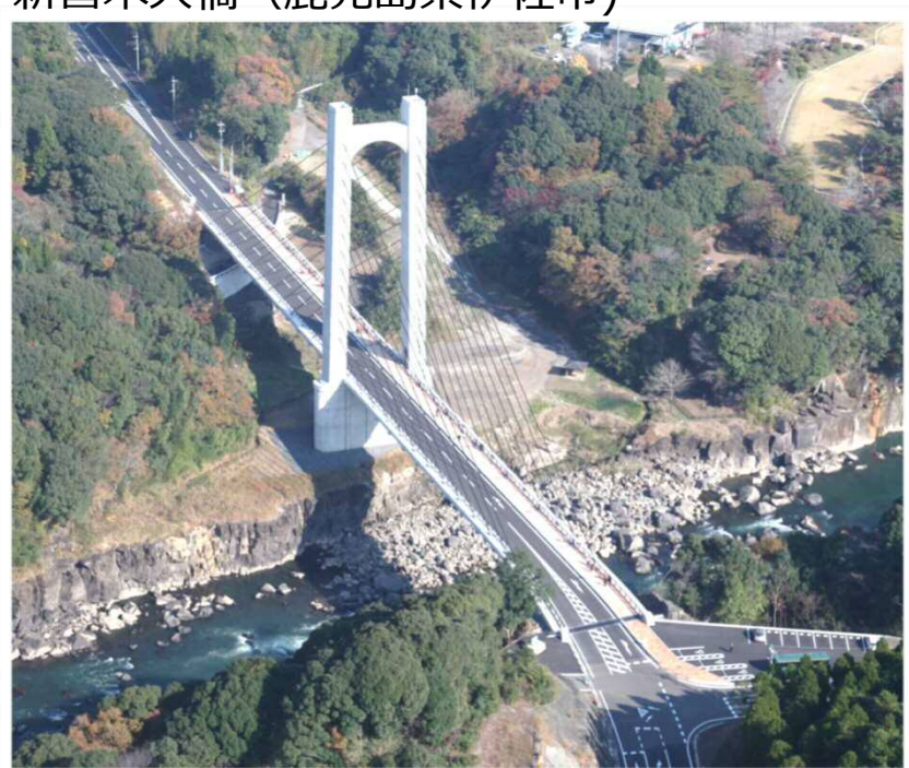
新曽木大橋 (鹿児島県伊佐市)
