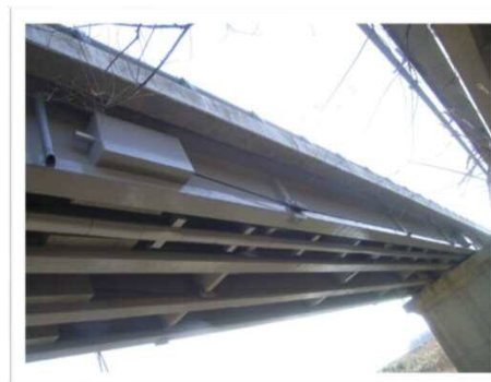
外ケーブル補強
