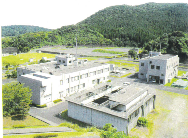
鹿児島市 平川浄水場
