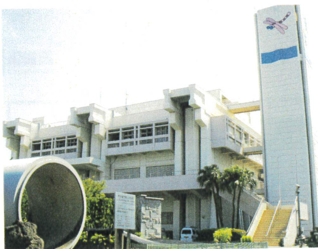
鹿児島市 南部処理場
