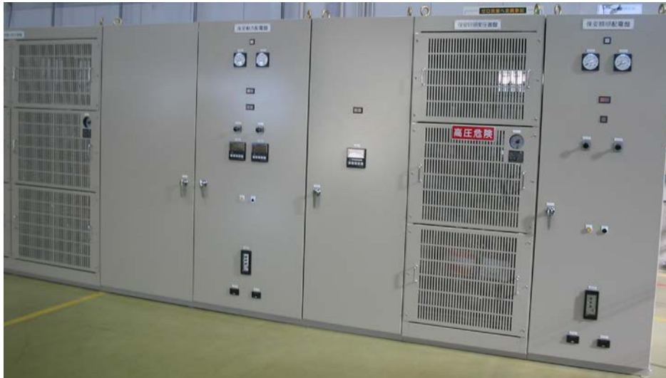
高圧受変電盤
