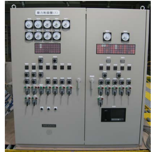
ポンプ制御盤・計装インターフェース盤
